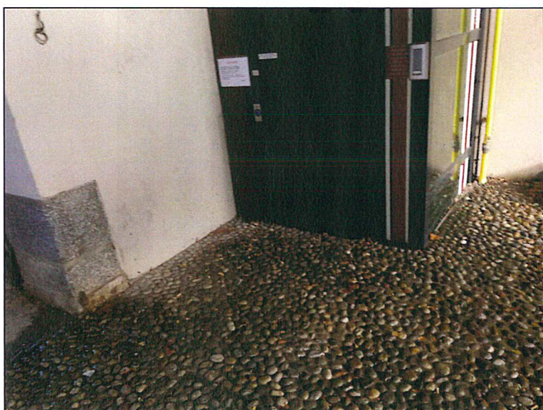
Vista piano sbarco vano montacarichi
