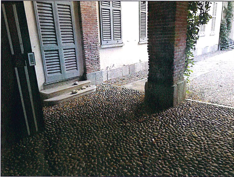
Vista collegamento e pavimentazioni di cortile
