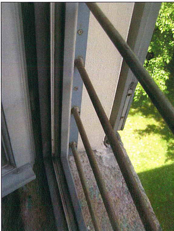
Particolare della tipologia della barriera
