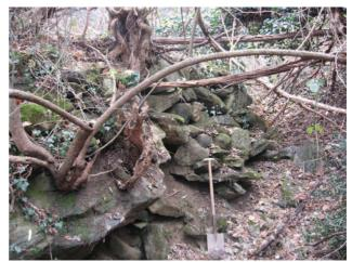
Fig. 6.73 Muro di contenimento in blocchi in alveo
