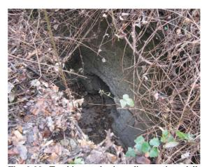
Fig. 6.66 Tombino e tubazione di captazione delle acque del torrente
