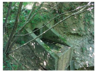
Fig. 6.54 L'opera di scarico delle acque stradali
