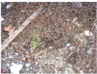
Fig. 6.70 E' appena visibile il bordo superiore della tubazione di scarico a Lambro, intasata da terra e rifiuti
